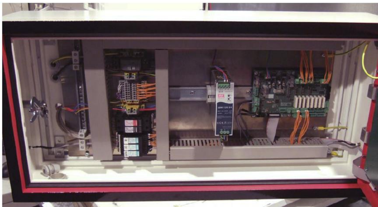
Bild 1.4: CAT-III Schild Innenansicht Standardaufbau mit Überspannungsschutzmodule
